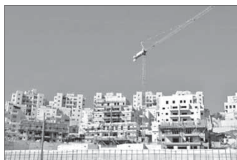
Строительство в иерусалимском районе Гар-Хома
