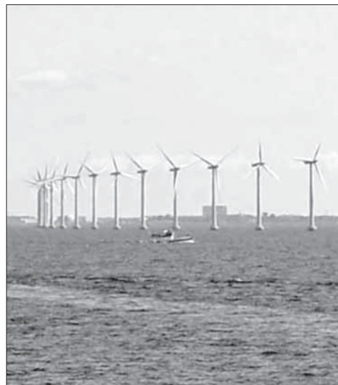
Прибрежная ветроэлектростанция в Дании
