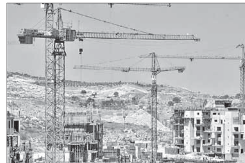
Строительство в Восточном Иерусалиме
