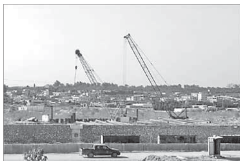
Строительство разградительного барьера
