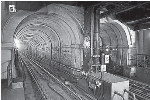
Вид туннеля на юг со стороны станции Wapping
