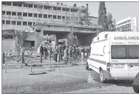
Здание в Дамаске, поврежденное взрывом
