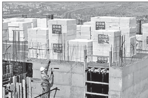
Строящийся дом в одном из еврейских поселений
